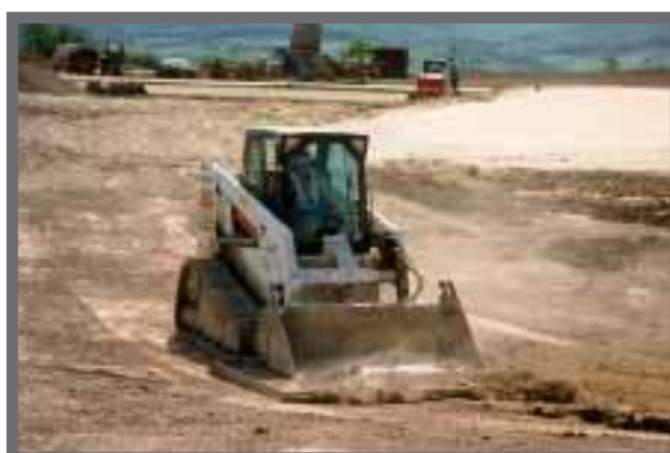
Bild 15: Gerade auf Golfplätzen muss das Feinplanum besonders sorgfältig erfolgen
