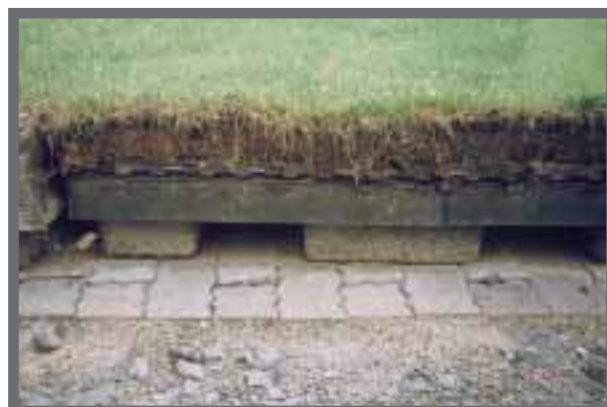
Bild 30: Für hoch beanspruchte Bereiche können Austauschelemente auf Trägerplatten eingesetzt werden.
