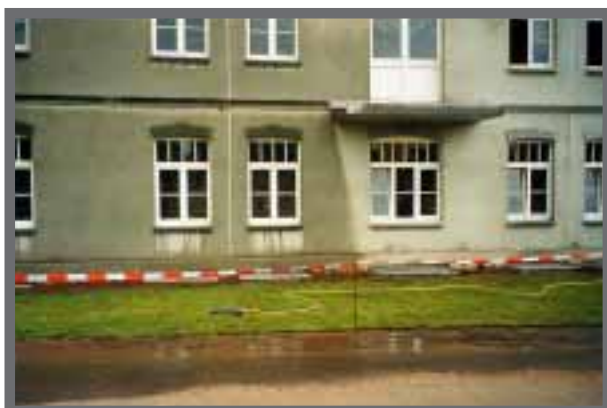
Bild 28: Nach dem Anwalzen ist nur der Rollrasen kräftig anzuwässern.
