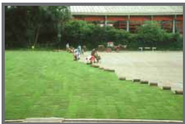
Bild 26: Das Planum darf nicht mehr betreten werden.
